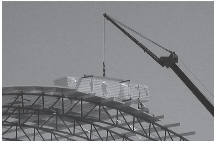
En la parte superior e inferior del material donde se colocarán las bandas, se recomienda utilizar un esquinero de madera o algún medio adecuado para proteger al panel al momento de maniobrar la grúa (para evitar marcar el producto por la tensión de la banda).
