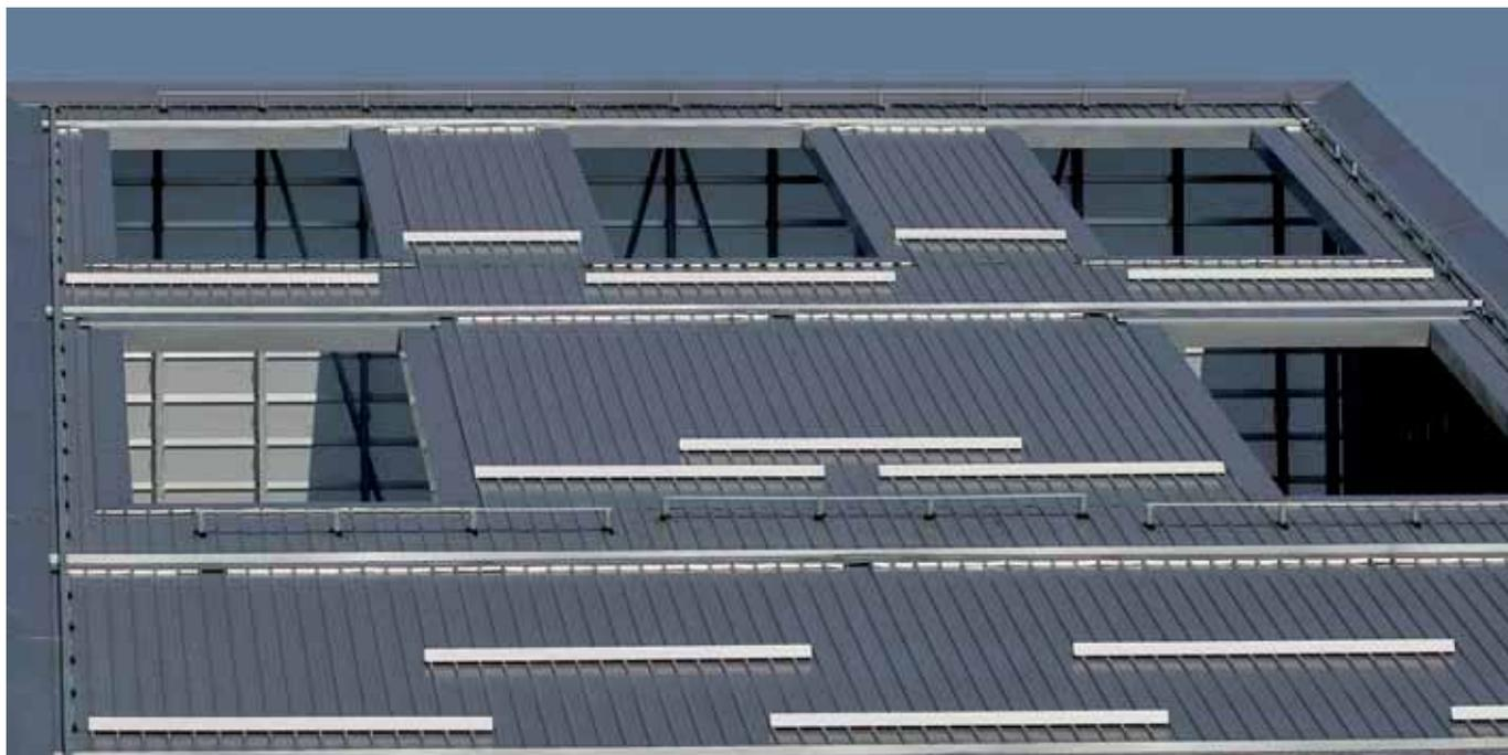
Panel sándwich de doble revestimiento metálico, para cubiertas con pendiente no inferior al 7%, aislado en lana mineral, con lámina exterior perfilada de 5 greclas para aumentar la resistencia a las cargas estáticas y dinámicas. La fijación es a vista con grapas metálicas con guarnición.
